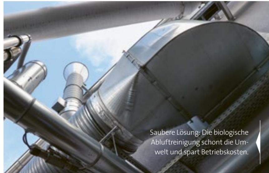
um sich zu vermehren. Die gefilterte Abluft gelangt schließlich über einen Kamin nach draußen. Der Prozess gleicht dem, was genau so in der Natur stattfinden würde – nur eben in der Anlage konzentrierter und kontrollierter.
