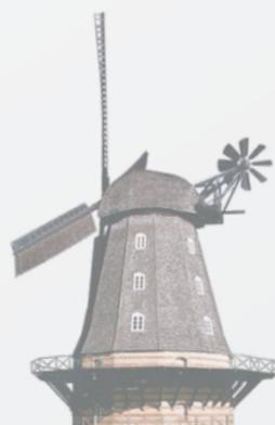
mühle, die ab dem 16. Jahrhundert ihren Siegeszug antrat. Deren Gebäude konnte bis zu 40 Meter hoch sein. Mit einer Flügelspannweite von über 20 Metern war sie in der Lage, bis zu 30 Kilowatt zu erzeugen. Mit der Industrialisierung schwand der Einfluss der Windmühlen, und im 19. Jahrhundert wurden sie mehr und mehr aufgegeben.
